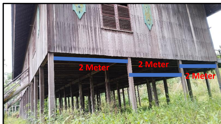
Gambar 3. Posisi dan Jarak Tiang Rumah Betang
